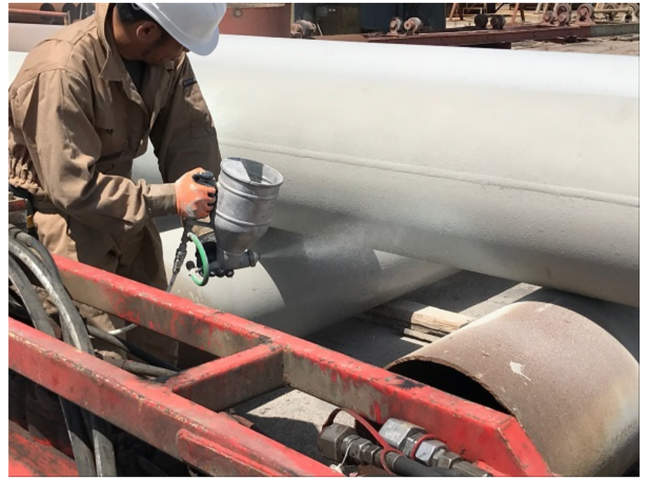
2層目(2回目)の施工状況
