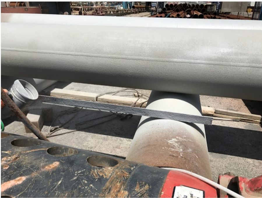
2層目(2回目)の施工完了後
