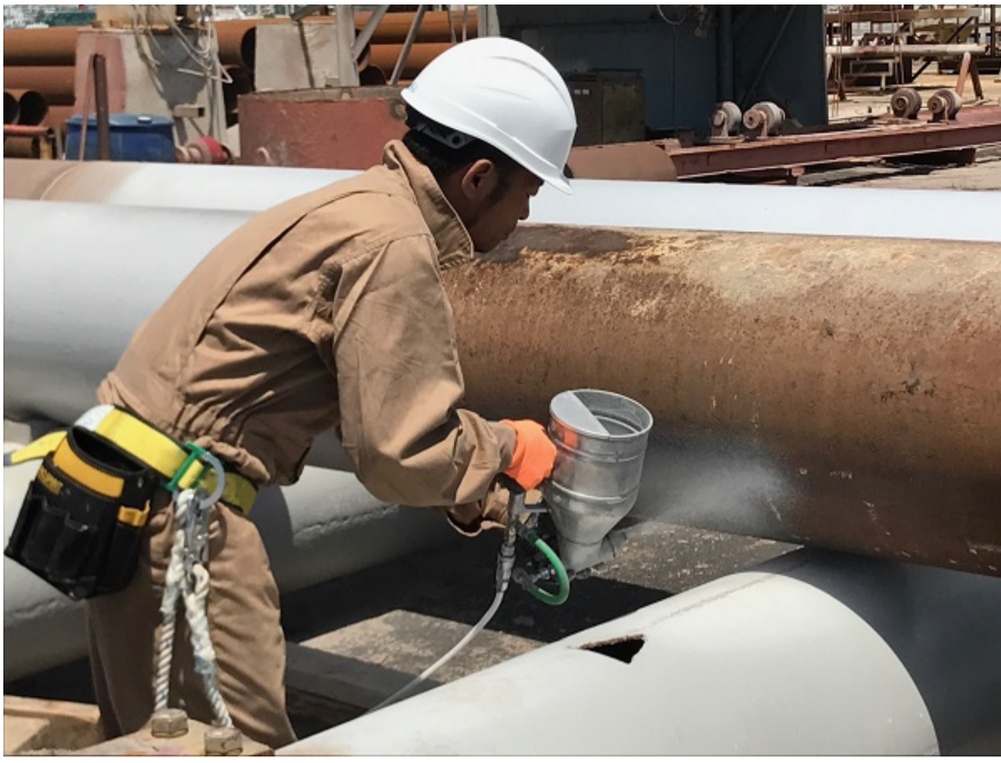
3種ケレン後の1層目(1回目)の施工状況
